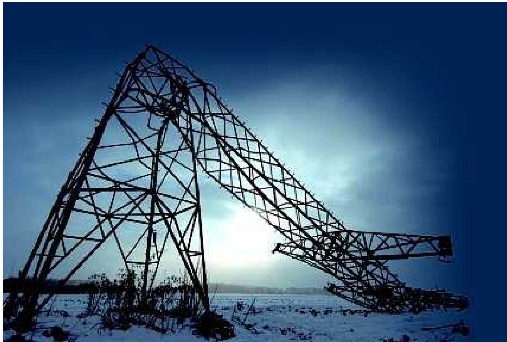
Collasso di una torre di una linea di trasmissione
